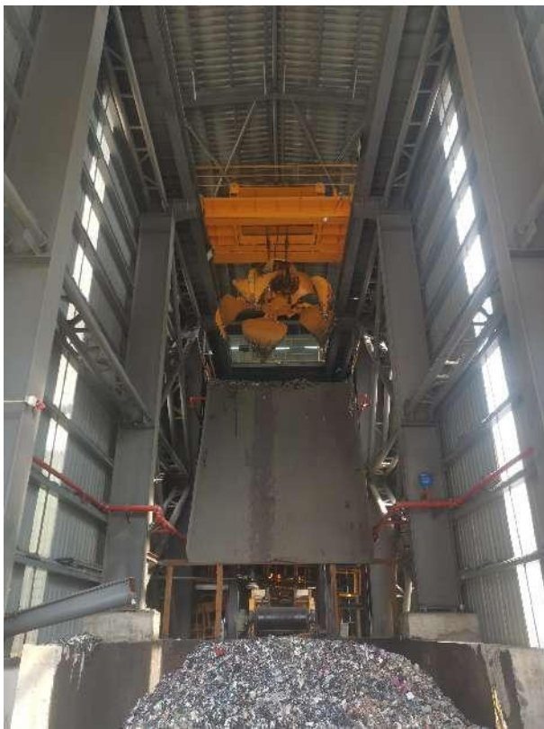
临时储库及入窑提升
