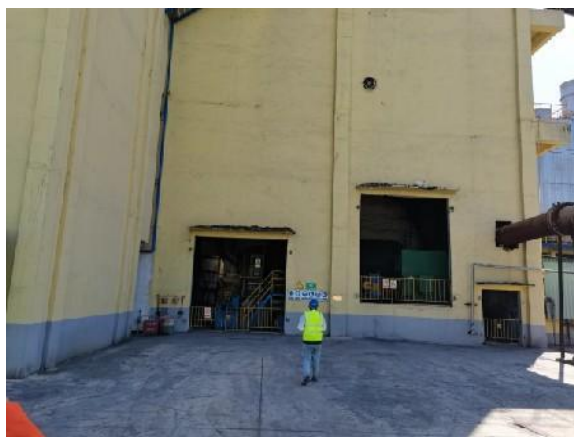
图 4-1 整改前（煤磨车间）
