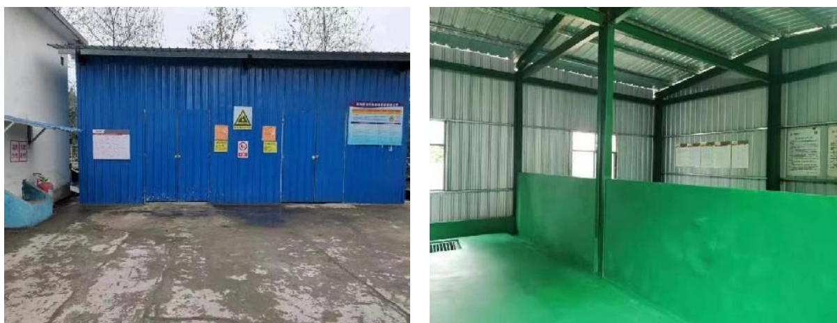
图 4-11 危险废物暂存间（整改后）
